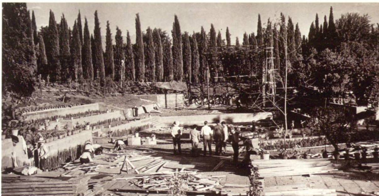
Construcción del Teatro del Generalife. Primavera de 1953. (Foto Torres Molina. AI)
